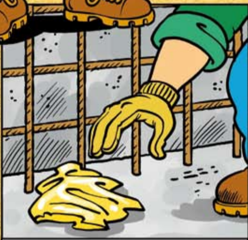
ENTFERNEN VON ABFÄLLEN AUS DER SCHALUNG.
