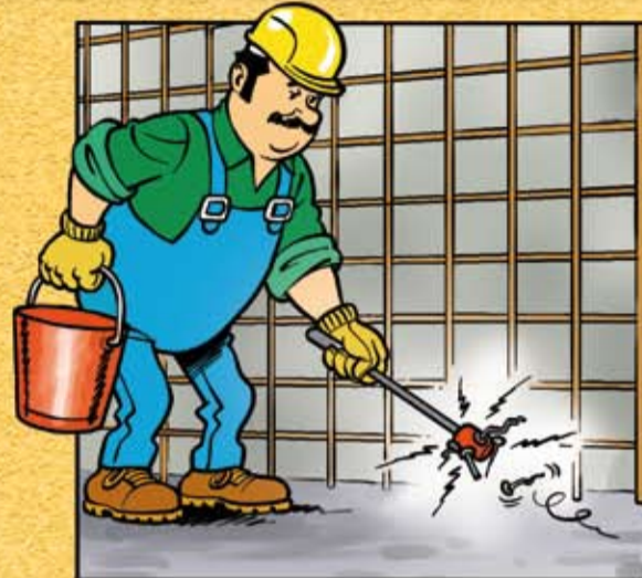
REINIGEN DER SCHALUNG MIT EINEM MAGNETEN UND WASSER.
